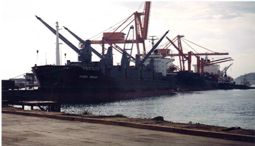
Fotografía 2. Naves y grúas de descarga.
